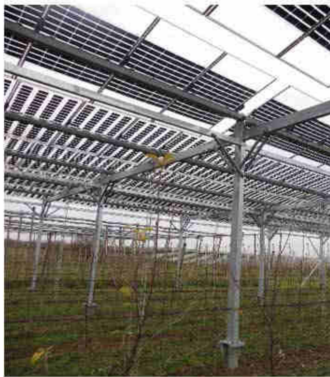
Figura 5. Aspecte de panells transparents que permeten el pas de la llum.
