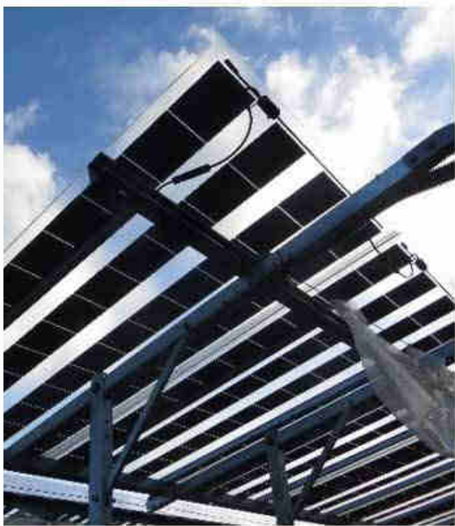
Figura 5. Aspecte de panells transparents que permeten el pas de la llum.
