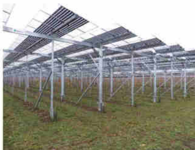
Figura 2. Disposició de postes de la estructura en cada fila (esquerra) o cada 4 fileres (dreta).
