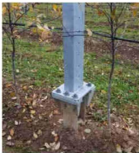
Figura 3. Detall dels postes amb sabata de formigó (esquerra) o clavats directament al terra (dreta).
